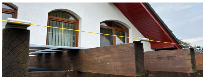
Obrázek 3 – Upevnění háčků do spodních nosníků
