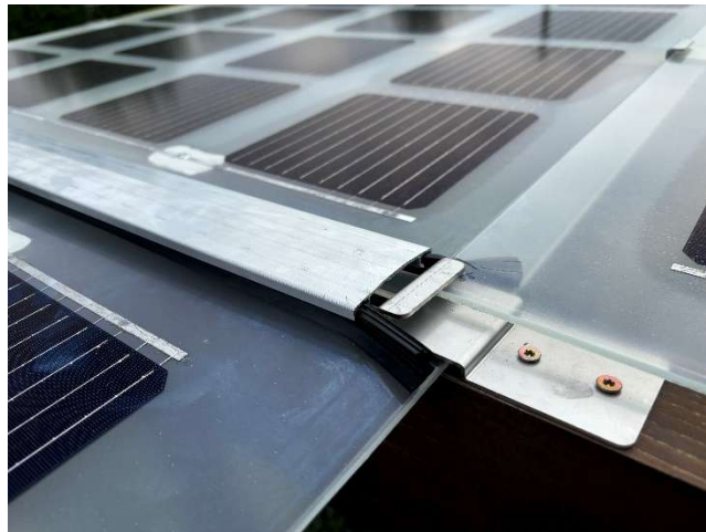
Obrázek 5 – Uložení panelu z boku a navázání horní řady
